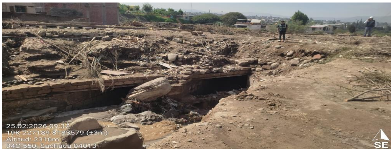
IMAGEN 02: SE OBSERVA EL PASE DEL AGUA Y EL ESTADO EN EL QUE SE ENCUENTRA LA ESTRUCTURA DE CONCRETO POR LA EROSION RECIENTEMENTE
