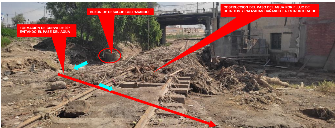
IMAGEN 04: SE QUE SE REQUIERE DE AMPLIACION DE LA LUZ DEL PUENTE DONDE PASE LA LINEA FERROVIARIA ASI MISMO SE NECESITA DE LA
