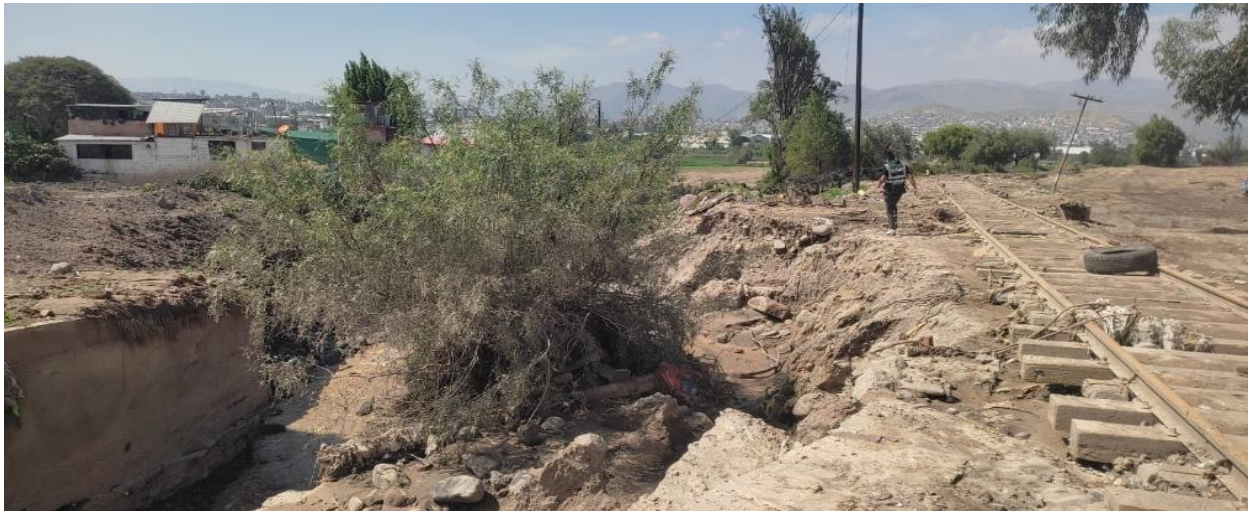
IMAGEN 03: SE OBSERVA LA VIA FERROVIARIA QUE HA SIDO INUNDADO POR EL HUAYCO OCASIONADO EN LA PARTE ALTA DE LA QUEBRADA CHULLO
